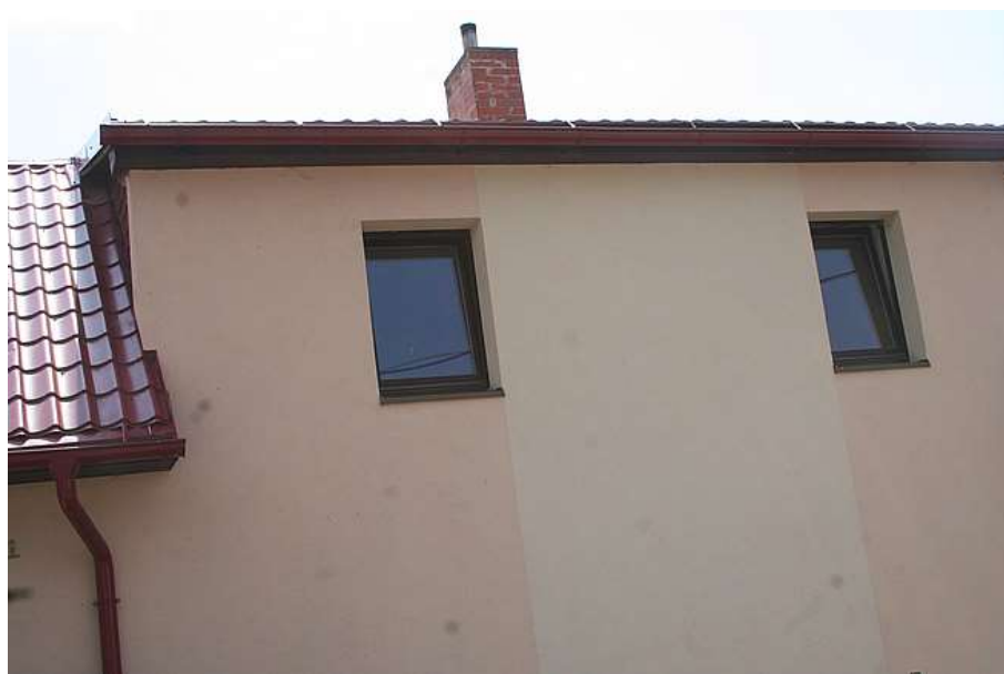
Obr. 4: Na těchto dvou oknech byl během roku 2017 zaznamenán úhyn minimálně pěti ptáků, převážně vrabců polních, jejichž hnízdění probíhalo přímo na budově.
