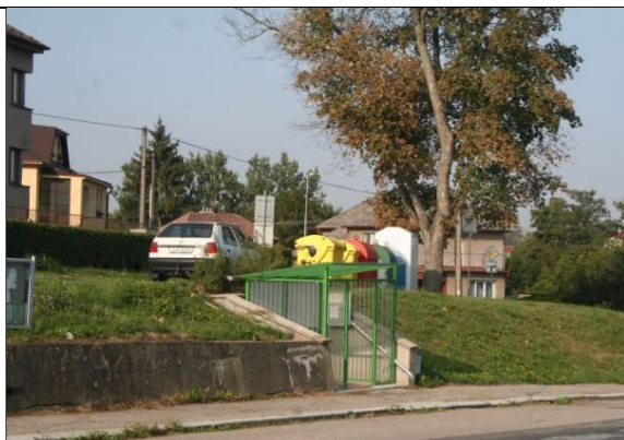
Havlíčkův Brod, Vysočany Blížkost husté vegetace Zabezpečena
