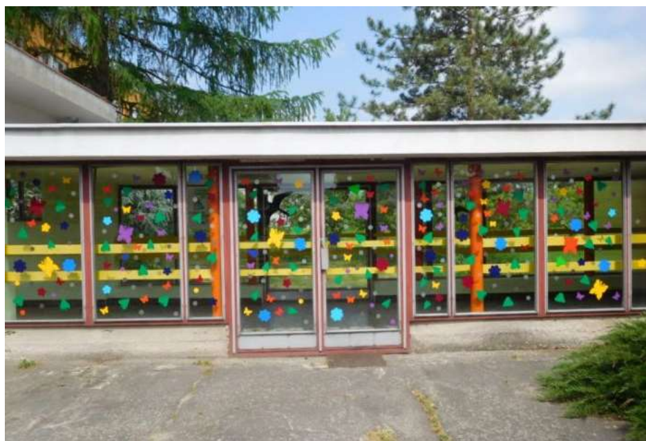
Obr. 22: Originální zabezpečení školní budovy ( www.krajskelisty.cz/olomoucky-kraj ).
