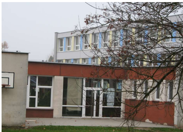
Obr. 30: ZŠ Wolkerova 2941, Havlíčkův Brod
