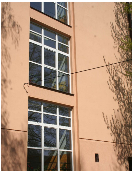
Obr. 31: V Sadech 560, Havlíčkův Brod
