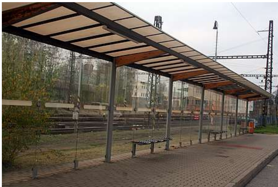
Obr. 3: Čiré sklo je pro ptáky neviditelné, větší plochy v blízkosti zeleně jsou extrémně nebezpečné (autobusové nádraží Havlíčkův Brod).
