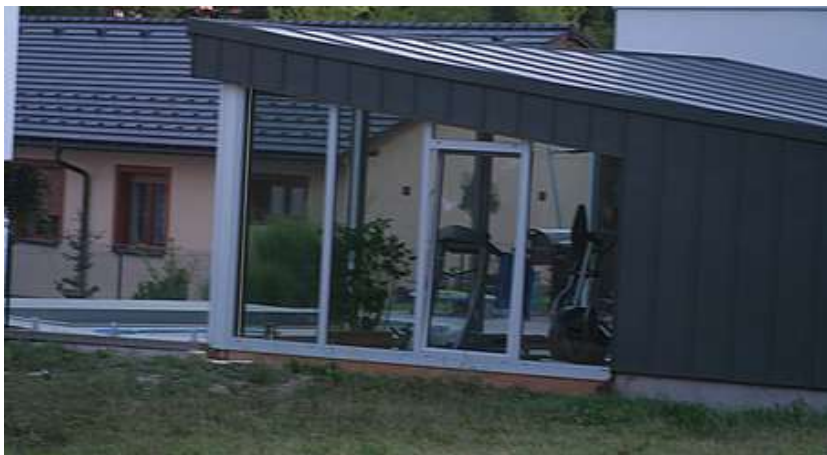
Obr. 38: Novostavba s velkými rohovými prosklenými plochami a se zelení v interiéru, potenciální místo častých kolizí.
