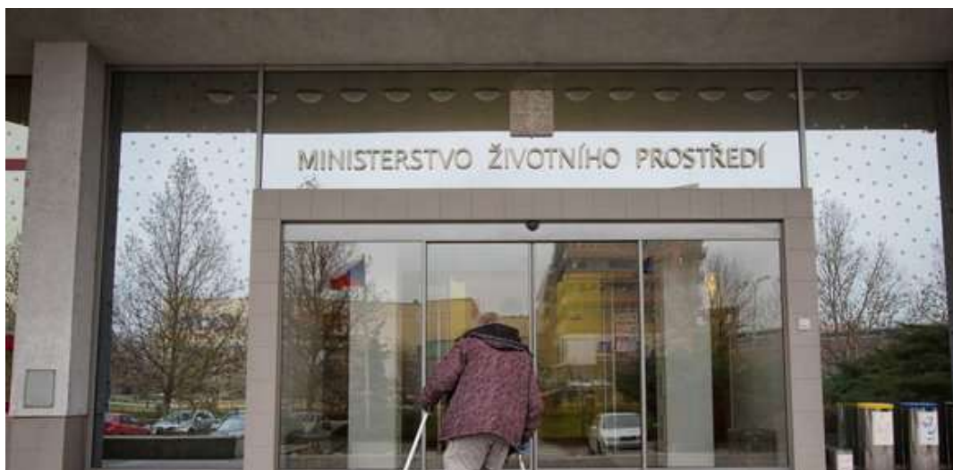
Obr. 21: Dodatečné zabezpečení transparentních skleněných ploch v přízemí budovy MŽP.
