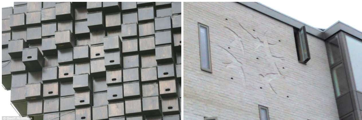
Obr. 1: Ukázky opravených nebo nově postavených moderních budov vhodných pro hnízdění rorýsů.
