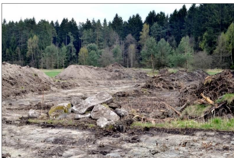
Obr. 18: Rašeliniště Chvojnov, průběh revitalizačních prací v roce 2013 (Dušejov, PR Chvojnov, 19.04.2014, Foto: V. Mrlík);
