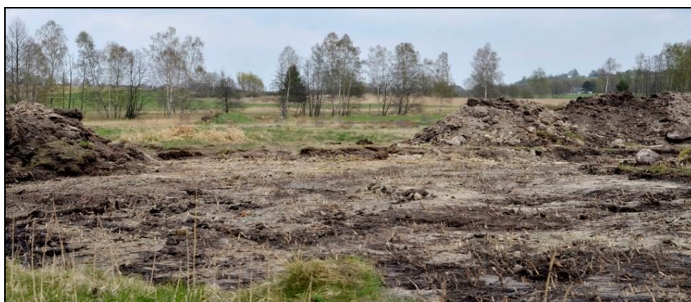
Obr. 17: Rašeliniště Chvojnov, průběh revitalizačních prací v roce 2013 (Dušejov, PR Chvojnov, 19.04.2014, Foto: V. Mrlík);
